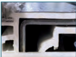
3 Stahlverstärkung im Mittelstoß
